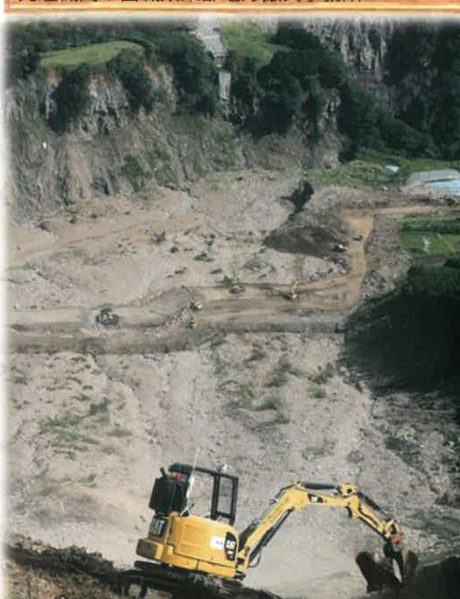
工事名称：阿蘇大橋斜面对策工事 施工場所：熊本県阿蘇郡南阿蘇村 発注機関：国土交通省 九州地方整備局
