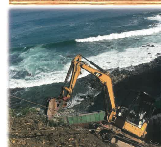
工事名称：金印海道法面改良工事 施工場所：福岡市東区大字勝馬地内 発注機関：福岡市
