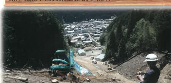
工事名称：公砂工第5-3号公共 防災・安全交付金 (通常砂防事業) 施工場所：郡上市八幡町小野地内 発注機関：岐阜県郡上土木事務所
