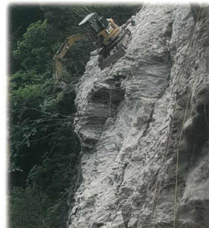
工事名称： 災害復旧村道柵の木～立野線道路補修斜面6 施工場所：熊本県阿蘇郡南阿蘇村河陽地内 発注機関：国土交通省 九州地方整備局
