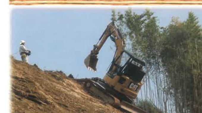
工事名称： 池崎地区急傾斜地崩壊防止施設災害復旧工事 施工場所：和歌山県海南市日方地内 発注機関：和歌山県海草振興局
